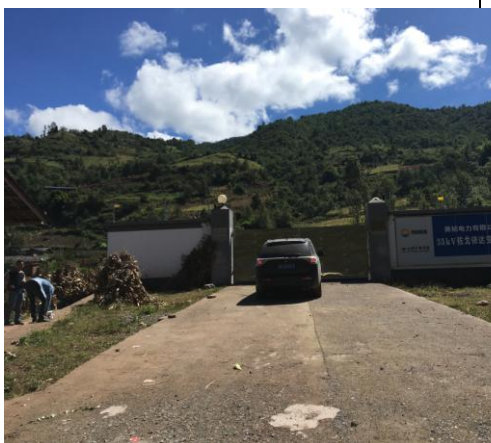
佐戈依达变电站进站道路
