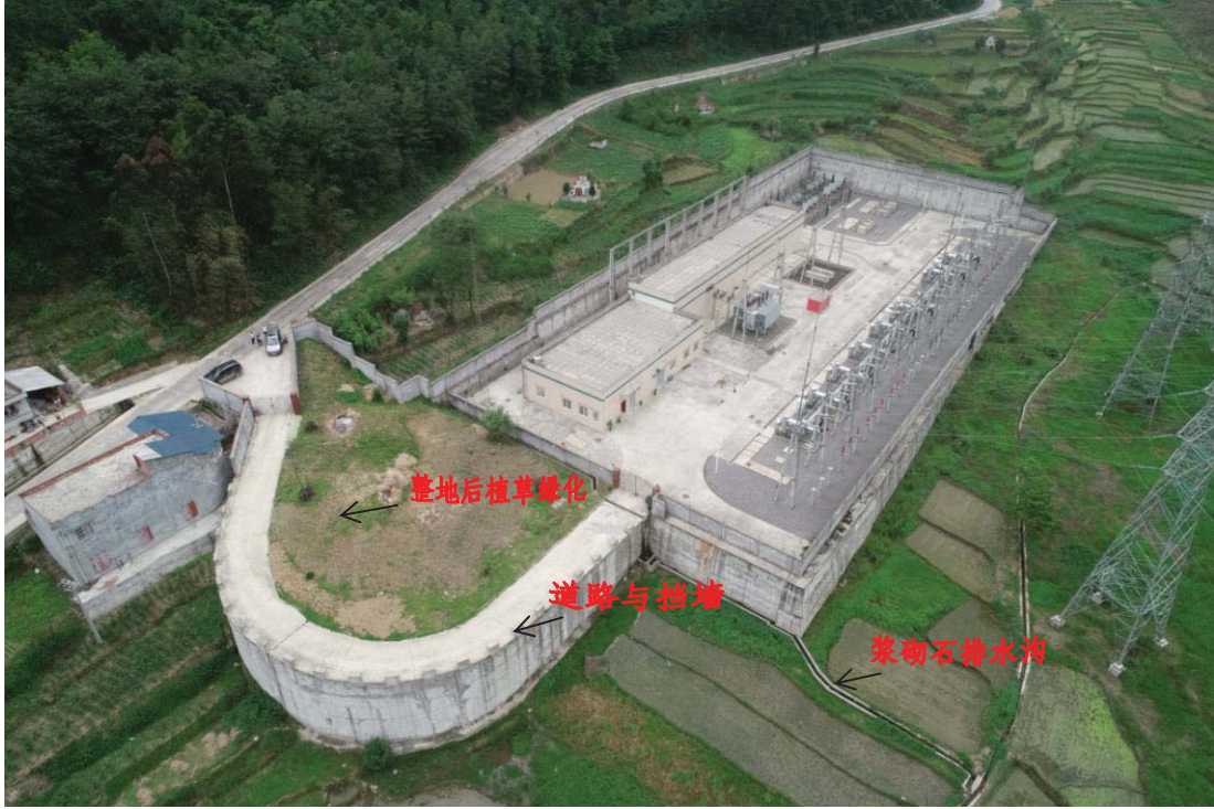
马嘶溪变电站
