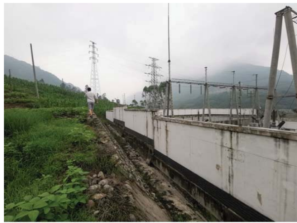
变电站旁边的浆砌石护坡与排水沟。
