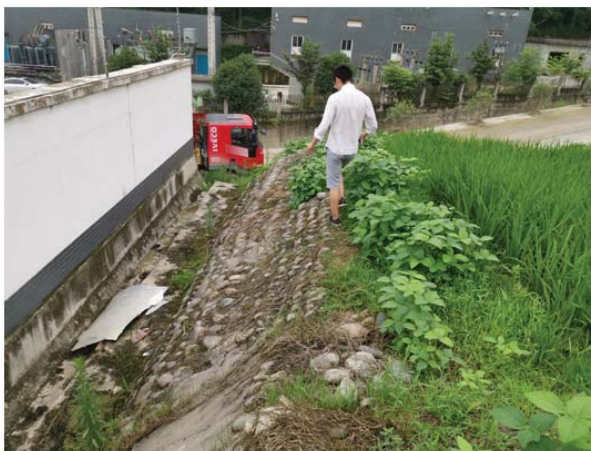
变电站旁边的浆砌石护坡与排水沟。
