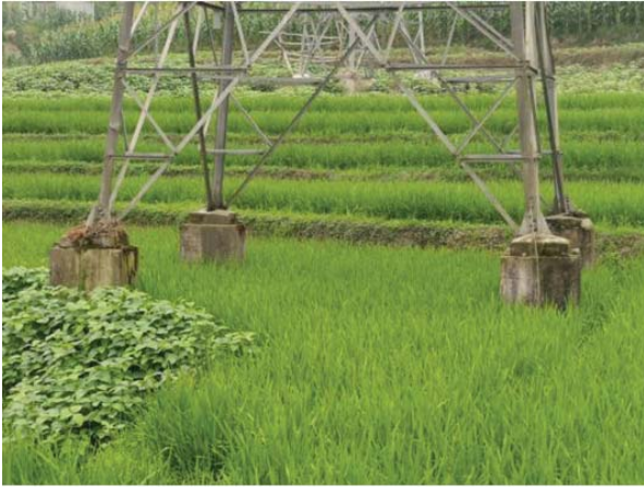
塔基础下整地后复耕。
