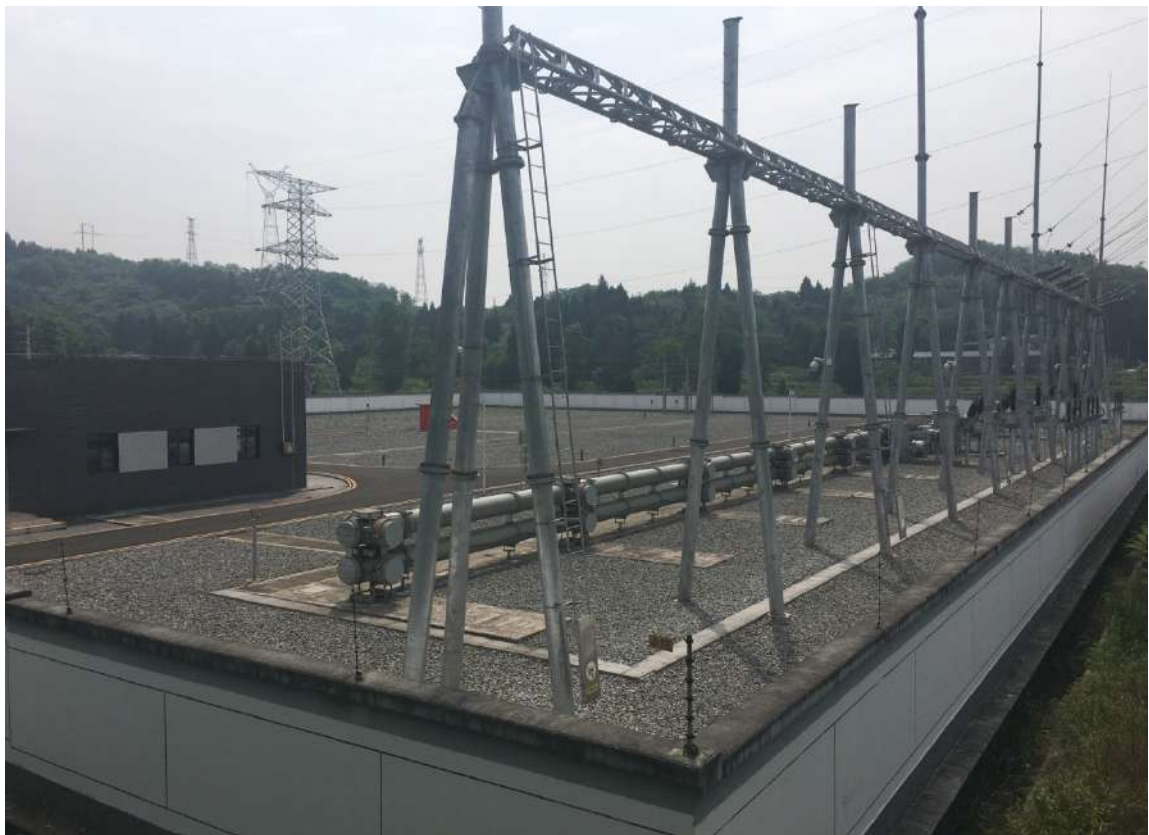
土溪变电站防治区站内地面碎石压盖工程（15cm厚碎石）
