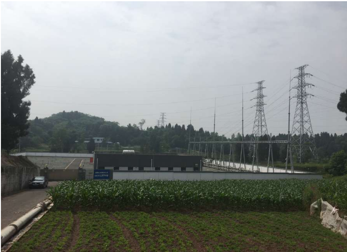
土溪变电站区临时占地区域土地复垦情况
