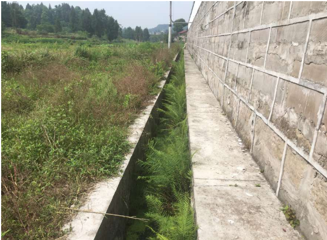
土溪变电站防治区站外排水沟工程
