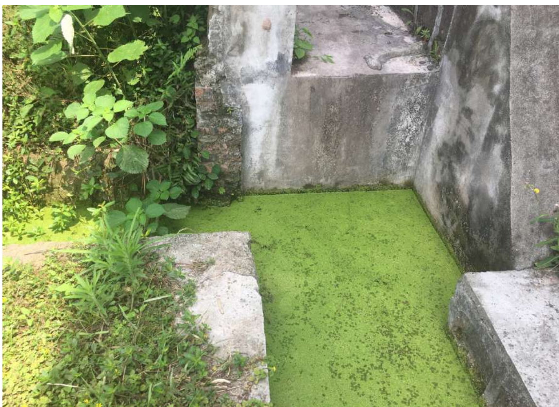
土溪变电站区站外沉砂池
