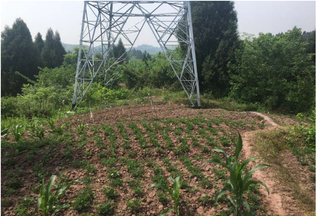
线路工程土地恢复情况
