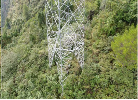
N63 塔植被恢复
