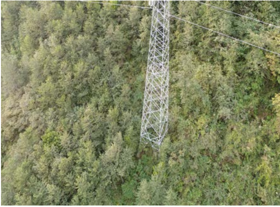
N60 塔植被恢复
