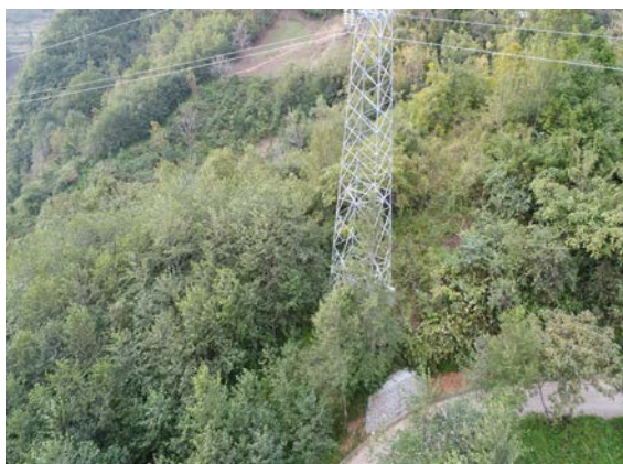
N62 塔（挡墙+植被）
