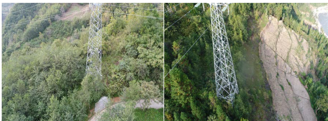
N62 塔挡土墙
