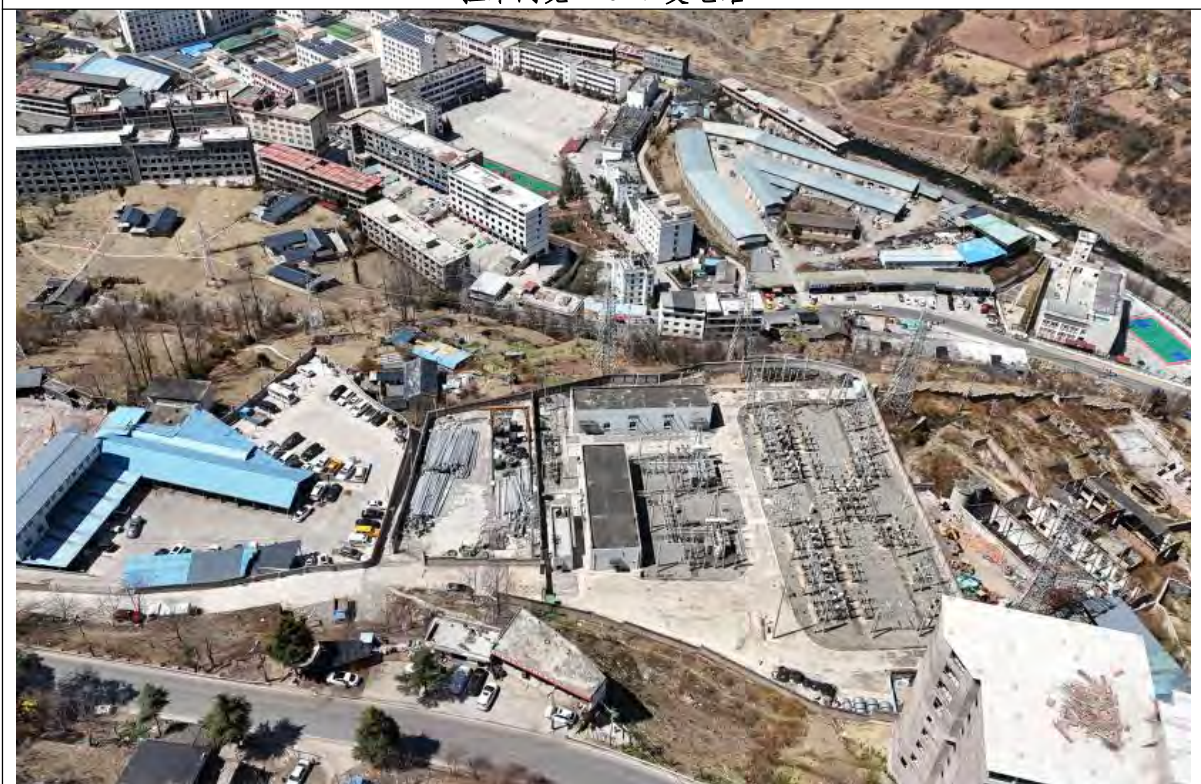
城关 110kV 变电站
